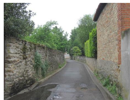
Murs à l'alignement, rue Maurice Berteaux
