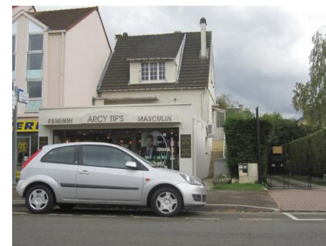
Extension sur l'avant d'un pavillon intégrant une activité, av. Paul Vaillant-Couturier
