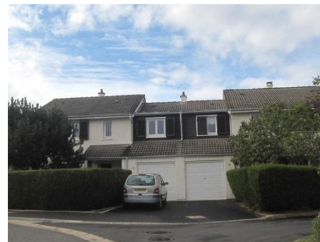
Rés. des Cèdres (1979) : maisons individuelles et maisons jumelées
