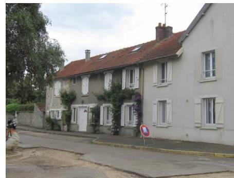
Maison maraîchère, 6 rue Camille Desmoulins
