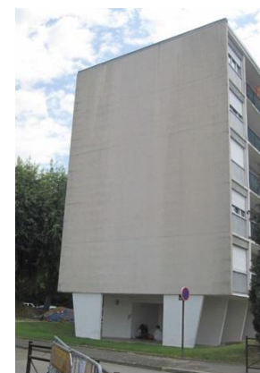
Rés. Hoche : Extrémités du rez-de-chaussée libre, structure en voile béton apparente.
