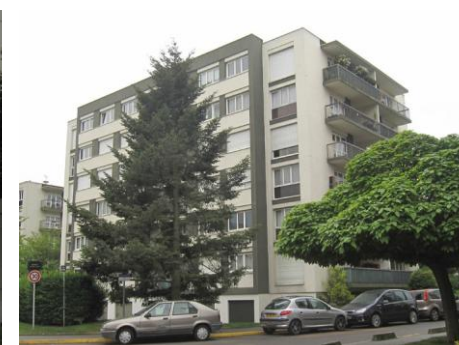
Rés. Champs d'Arcy 1 : Une façade lisse vitrée, des balcons filants en saillie sur le pignon, un enduit bicolore mettant en relief la façade
