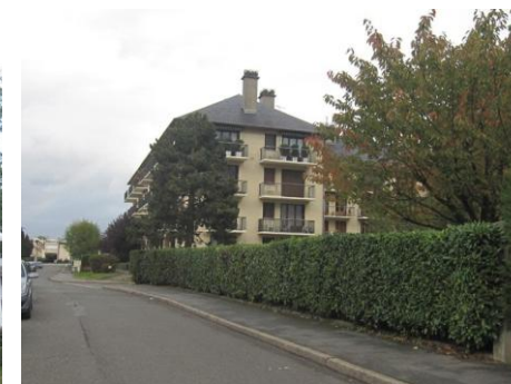
Rés. la Tremblaye : Toiture à pentes en ardoise et balcon filant en saillie
