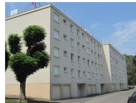
Rés. de la Forêt : un exemple de plot Une façade aux petites fenêtres répétitives
