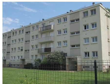
Rés. les Lilas : un exemple de barre Une façade avec l'émergence des premiers balcons
