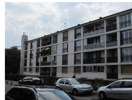
Rés. les Perdreaux : Une façade largement vitrée avec balcons filants à barreaudage ouvert
