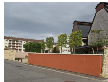
Réécriture contemporaine du mur à l'alignement, ferme de la Tremblaye
