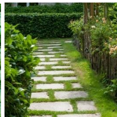
Pavés à joints enherbés
